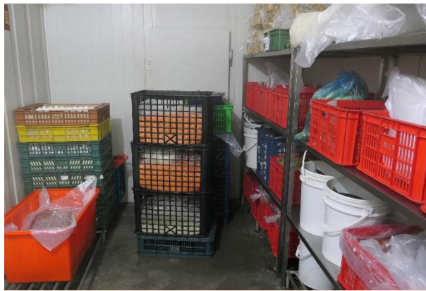
冷藏庫地面重新鋪水泥，食材均有墊高離地與覆蓋
