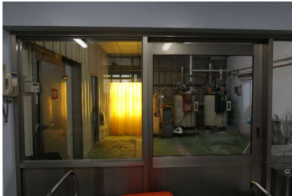
4/9:今年3月新增區隔牆， 區隔鍋爐區與前處理氣流
